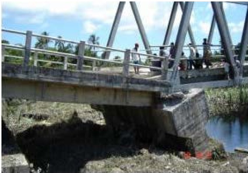
2005年インドネシアニアス島地震における 橋梁の液状化被害
