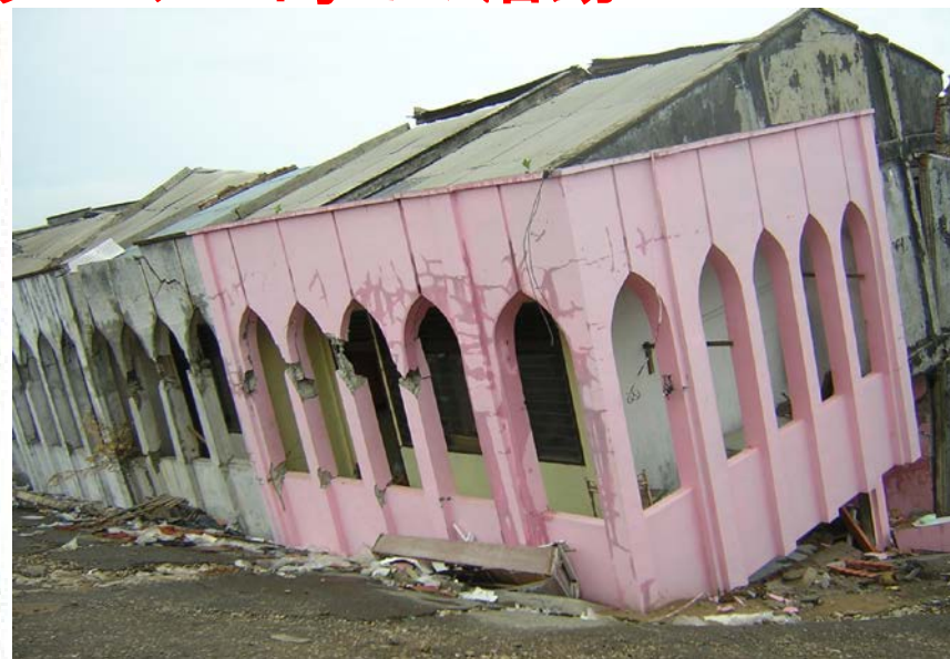
液状化による建物の倒壊
